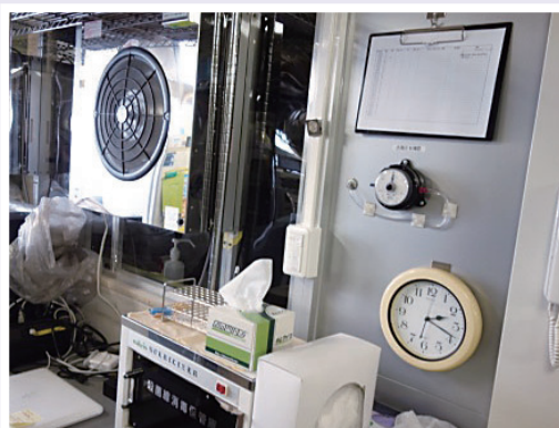
參觀其新設置的 BSL-3 設施—BSL-3 實驗室所設置之排風出口。
