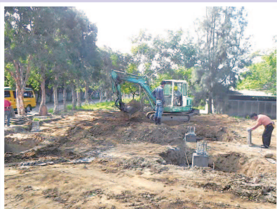
整地、放樣、開挖、基礎版底筋及柱組立
