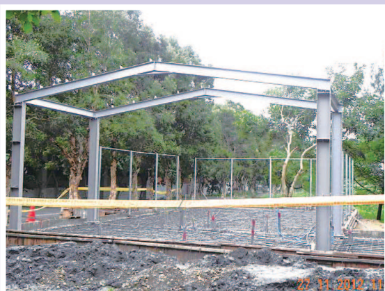
版鋼筋組立、水電配管、鋼構安裝
