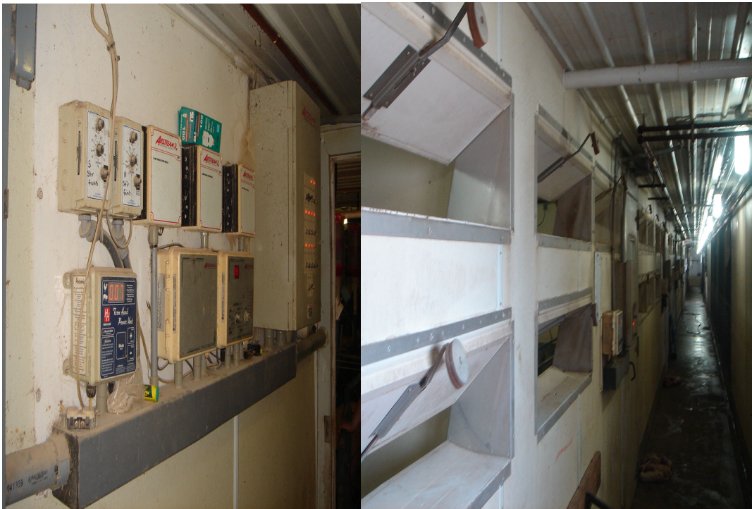
圖二、設施通風系統皆為電腦自動控制，以維持室內恆溫。
