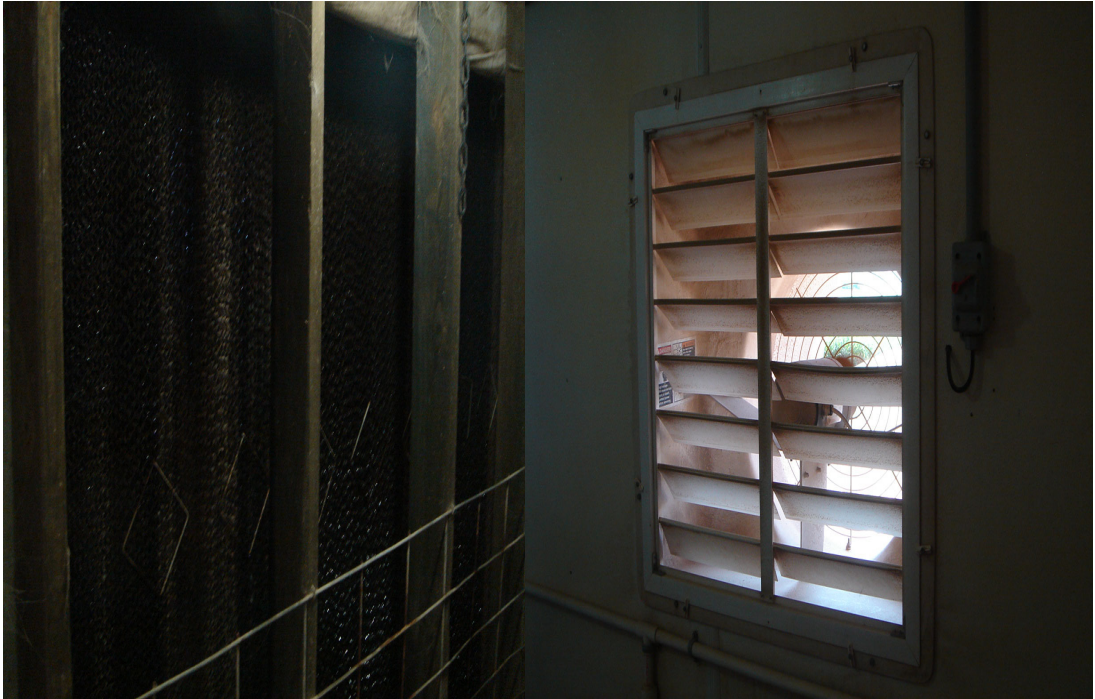
圖一、豬舍以水簾輔以風扇抽風來控制室內溫度。
