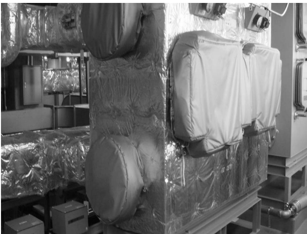
圖二十一、實驗室供氣管道特別以保溫裝置包覆，防止溫度散失。
