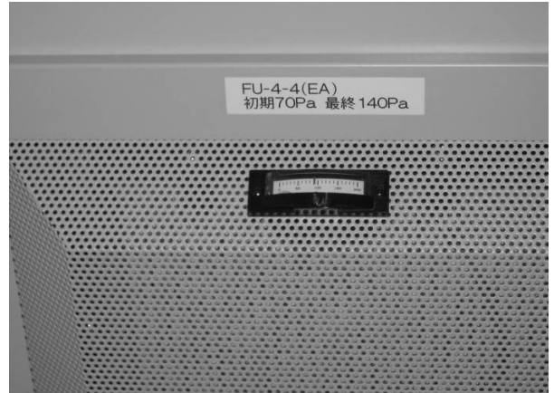
圖八、不同處壓力檢測表所需正常負壓範圍不同。
