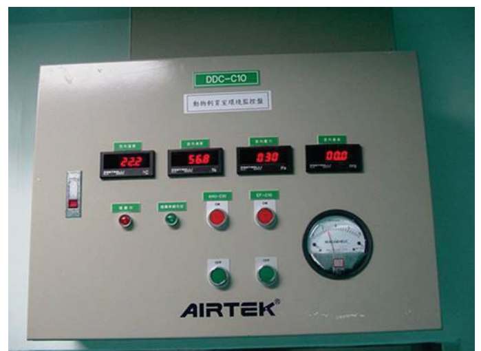
圖 8、動物飼育室內壓差、溫度、溼度及氨濃度監測器
